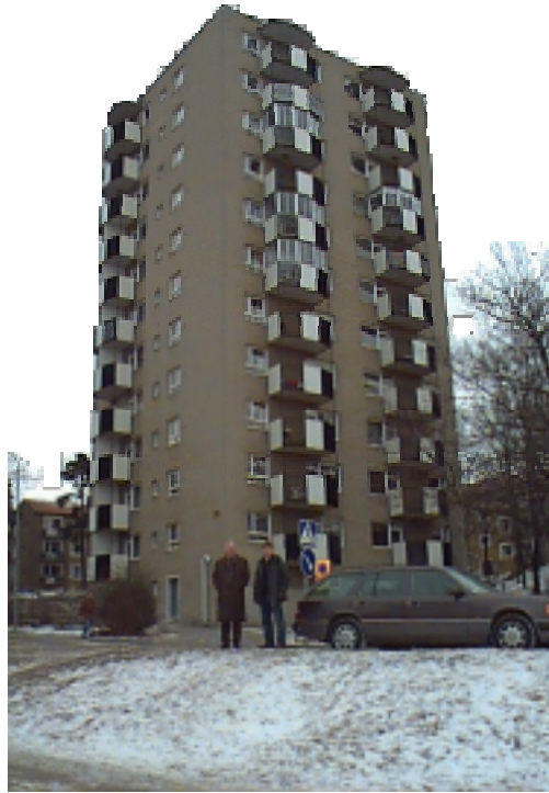
Figur 11. "Testbädden Vällingby" – bostadshuset på Jämtlandsgatan 152 i Vällingby där de första IT-tjänsterna installerats och utvärderats .
